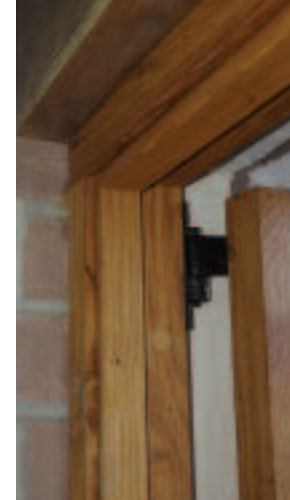
garage door frame
