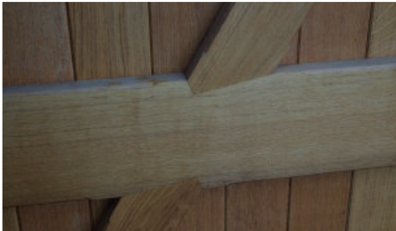
garage door brace detail
