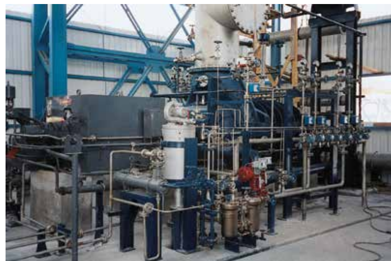
Soda Sanayii, Mersin (Türkei), Verdichtung von Kalkofengas VRO 836 L, Ansaugvolumenstrom von 45.000 m 3 /h, Verdichtung von 0,85 auf 3,5 bar (abs.), wassergesperrte Kohlelabyrinthdichtung
