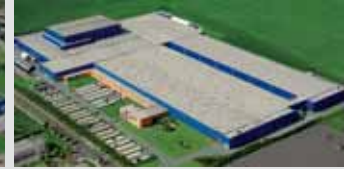
Hörmann KG Ichtershhausen, Germany
