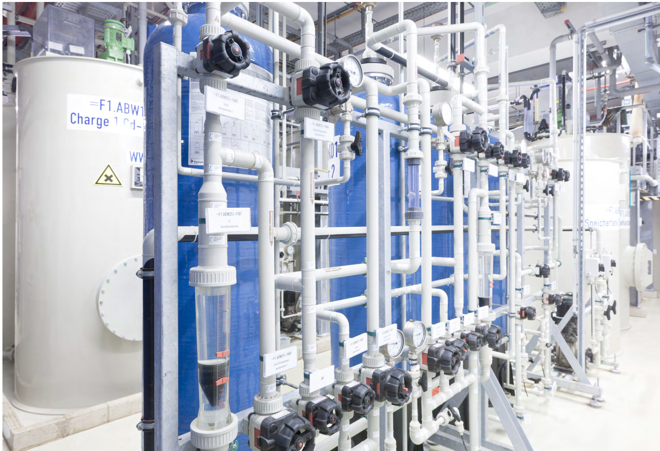
Selektiv-Ionenaustauscher-Anlage zur Entfernung von Cadmium.
