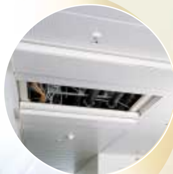
Messe Nürnberg Frankenhalle
