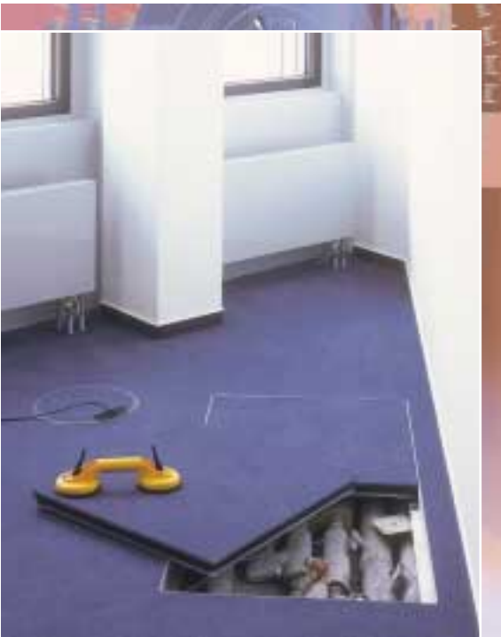
Doppelboden Typ Lintec mineralisch verfüllte Stahlwanne
