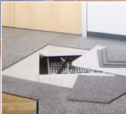
Doppelboden Typ Nortec, mit selbstliegendem Belag Nortec type access floor with self-lying flooring Faux plancher de type Nortec avec revêtement adhérent
