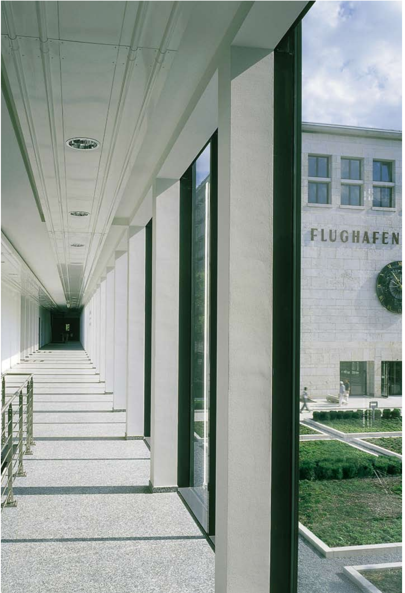
Munich-Riem airport, entrance hall, Munich (D)
